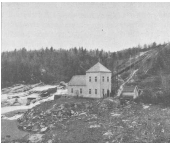
Kraftstationen (før utvidelsen).
